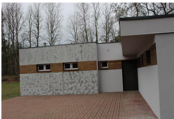
Szatnia sportowa Sieniawa Żarska
