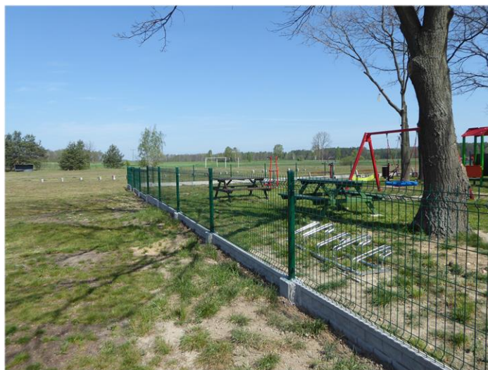
Ogrodzenie placu zabaw w Złotniku
