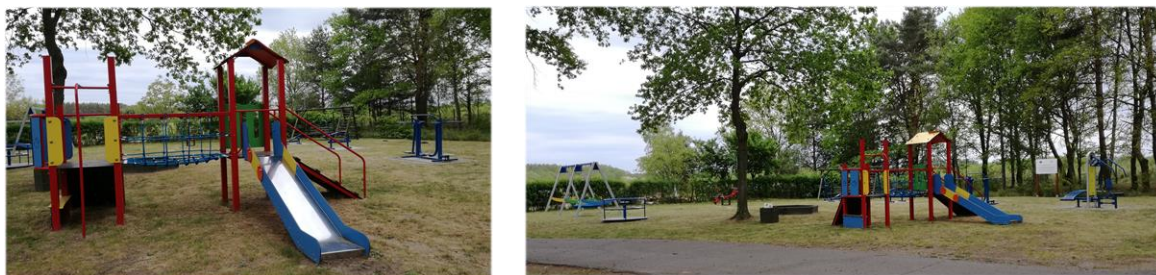
Budowa placu zabaw w Biedzychowicach Dolnych
