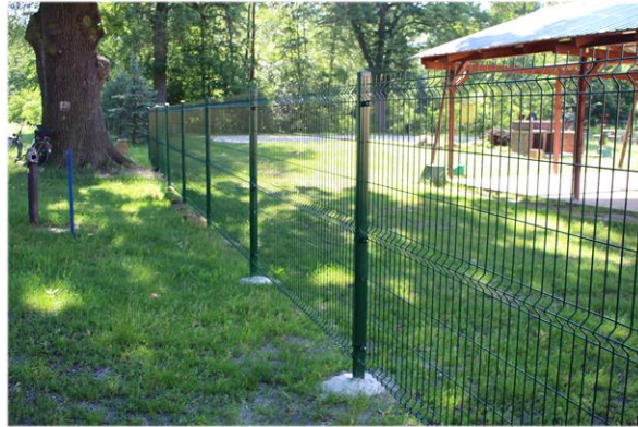
Wykonanie ogrodzenia placu zabaw w Bogumiłowie
