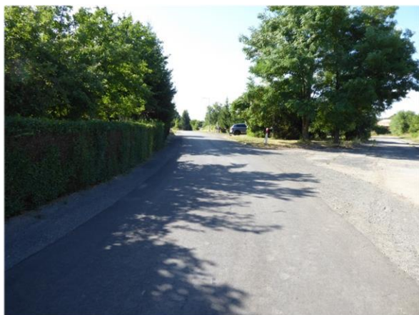
Budowa drogi w m. Bieniów
